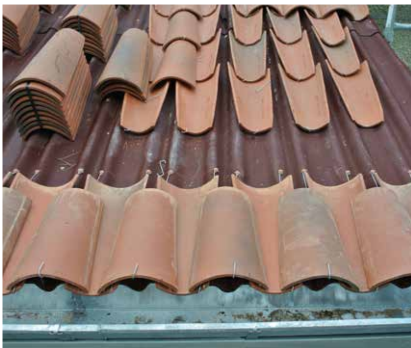
▲ ONDULINE® FLEXOUTUILE en pose tuile canal.
